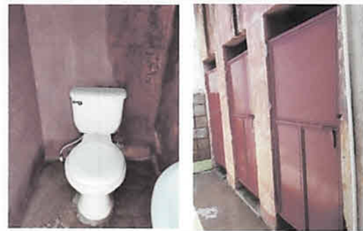
Foto 7 y 8: Mantenimiento a estructura (lijado, cambio de tubo, cepillado, sujeciones, aplicacion de pintura) a puertas servicios sanitarios y sustitucion de inodoro
