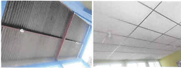
Foto 3: SUSTITUCION DE ILUMINACION Y FUERZA EN CORREDOR, DIRECCION, AULA 1 Y 2
