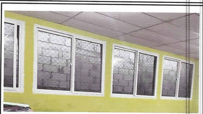
Foto 10: Ventanas pvc instaladas
