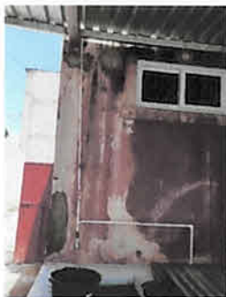
Foto 6: Sustitucion de accesorios deposito de agua
