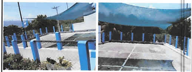
Foto 2: Cambio de malla en muro perimetral y area de patio 1 y 2
